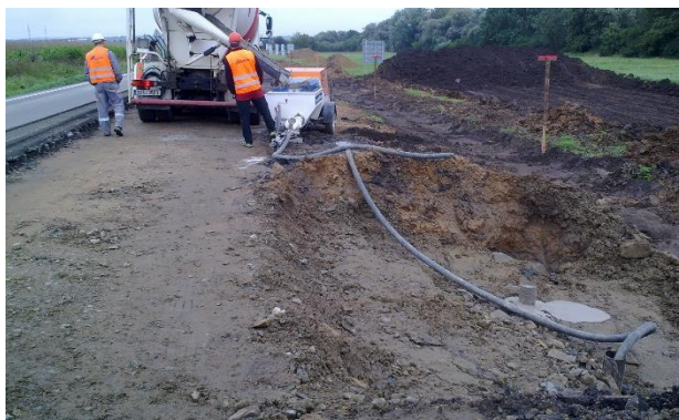
Beztlakové plnění kanalizace (potrubí rozděleno na několik sekcí vzdálenost přibližně 400 metrů)
