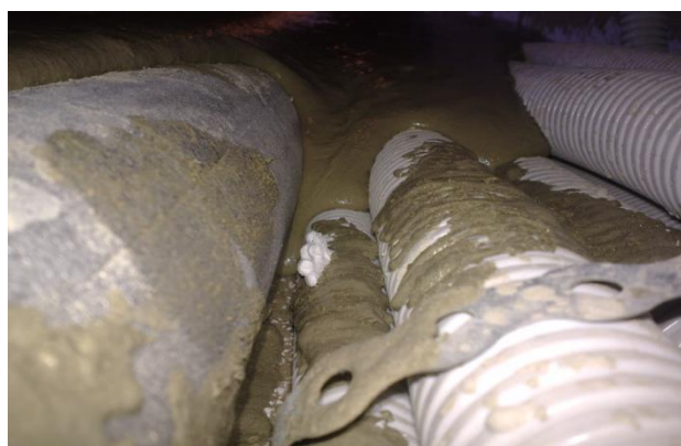
Dokonalé obtékání rozvodů v podlaze
