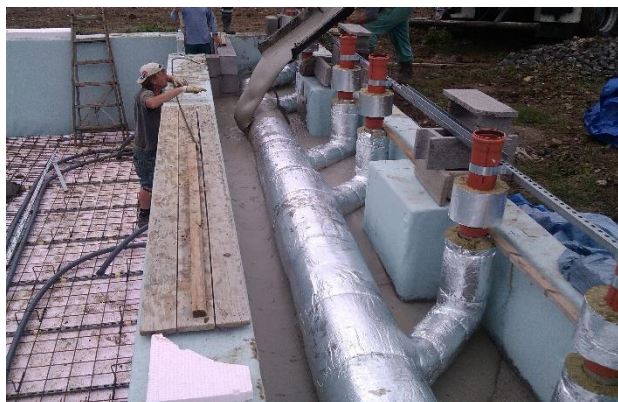
Stabilizace a dodatečná tepelná izolace potrubí
