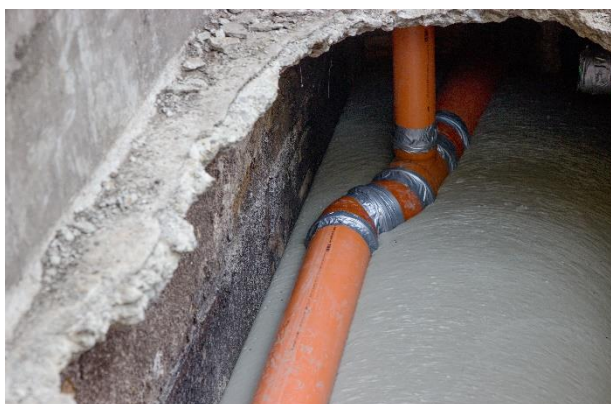
Vyplnění prostoru a stabilizace potrubí ve staré jímce
