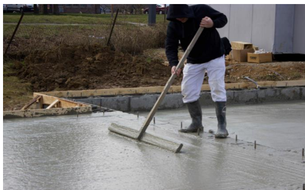
Vytvoření stabilního podloží pod RD
