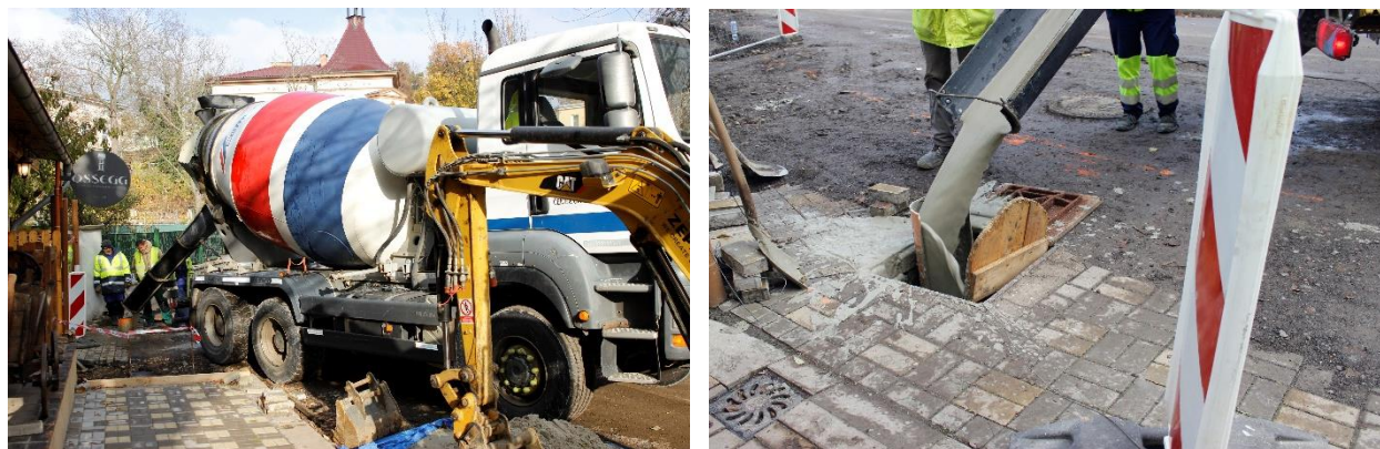
Nečerpací plnění (tzv. na volno) v městské zástavbě
