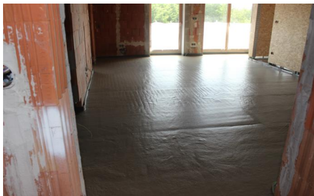
Izolace a vyrovnání podlahy (rozvody, nerovnosti)
