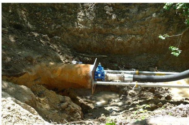
Příklad tlakového plnění
